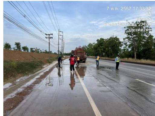
รูปที่ 9 จุดล้างล้อรถก่อนออกนอกโครงการ
